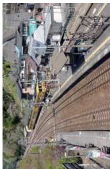
入構する下り列車 大歩危橋より
